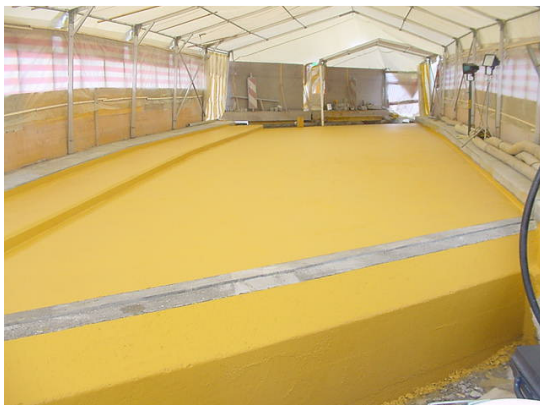
Neue Brücke mit FLK – Abdichtung
